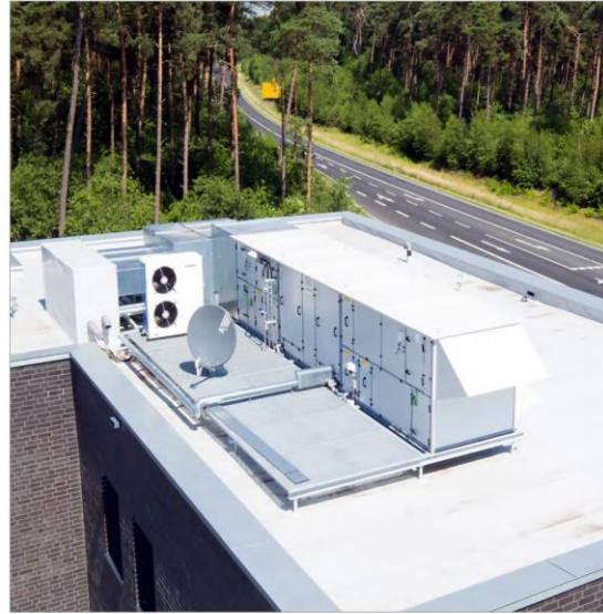
Kälterückgewinnung vor mechanischer Kühlung
